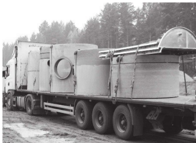
Fig. 12 Transport av förtillverkade betongelement
