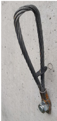
Fig. 11 Rätt monterat rundsling till det förtillverkade betongelementet
